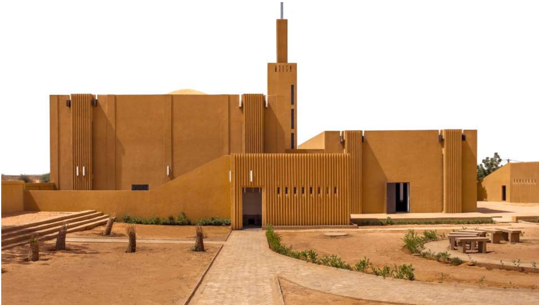
Restauration mosquée de Dandadji et centre communautaire – Atelier Masoni
